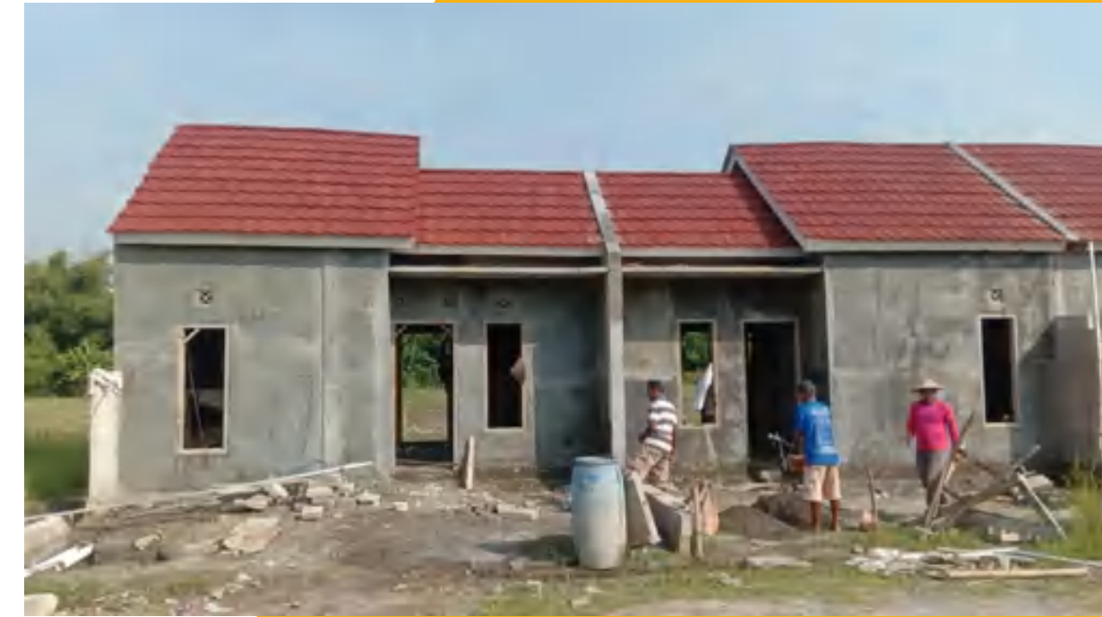
Progres Pekerjaan 70% : 2 Mei 2024
