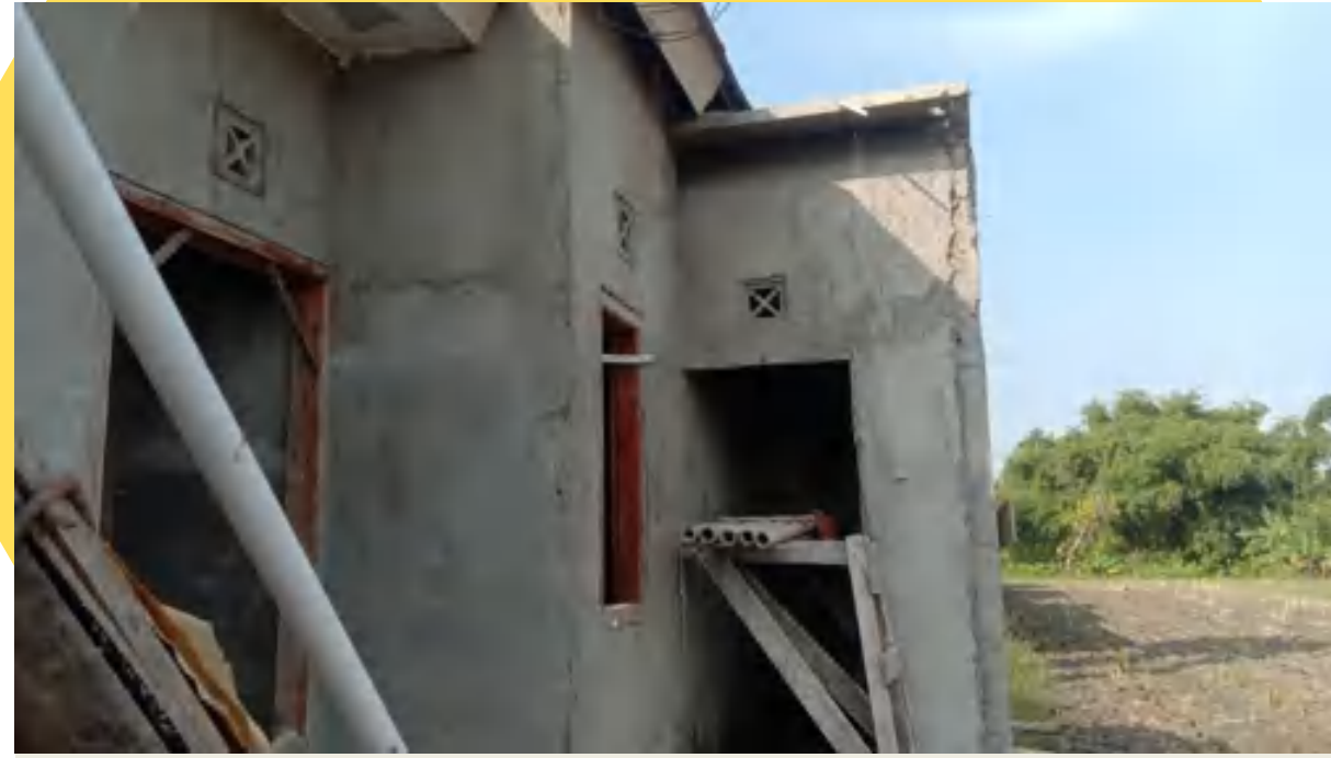
Progres Pekerjaan 70% : 2 Mei 2024
