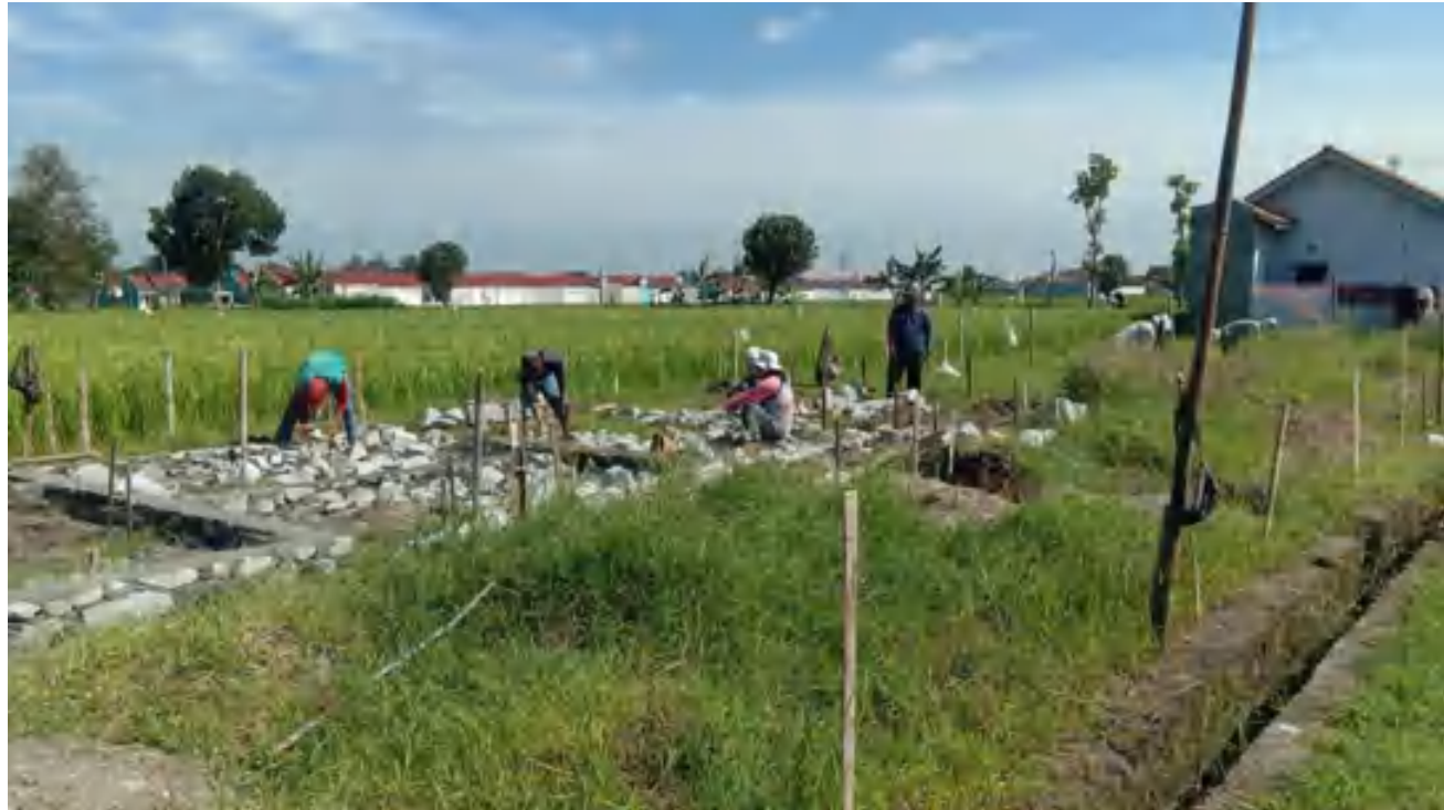
Progres Pekerjaan : 19 Maret 2024
